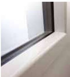
Glaçage du profil PVC.
