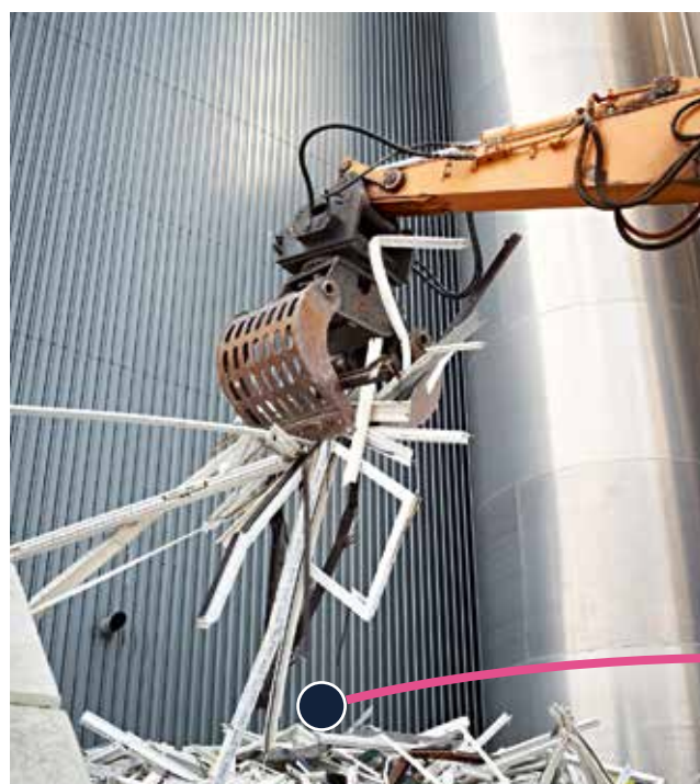
Collecte des anciennes menuiseries PVC.
